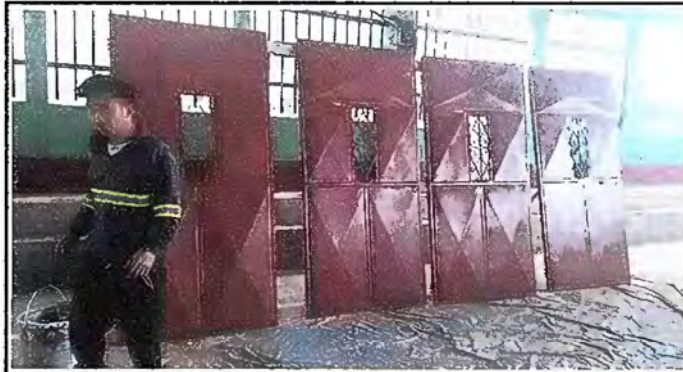
Foto 2: Módulo 1 (Planta baja y alta) - Mantenimiento a estructura de puerta (lijado, cambio de tubo, cepillado, sujeciones, aplicación de pintura).
