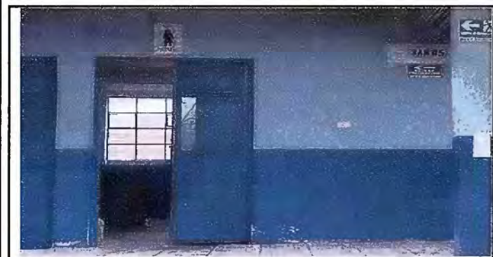
Foto 5: Módulo 2 (Planta alta y baja)- Mantenimiento a estructura de puerta (lijado, cambio de tubo, cepillado, sujeciones, aplicación de pintura).
