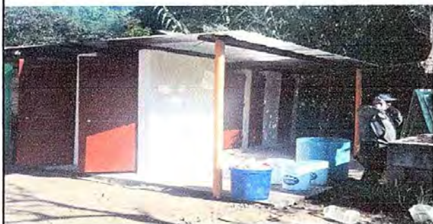
Foto1: Modulo 1. Sustitucion puerta de metal en baños
