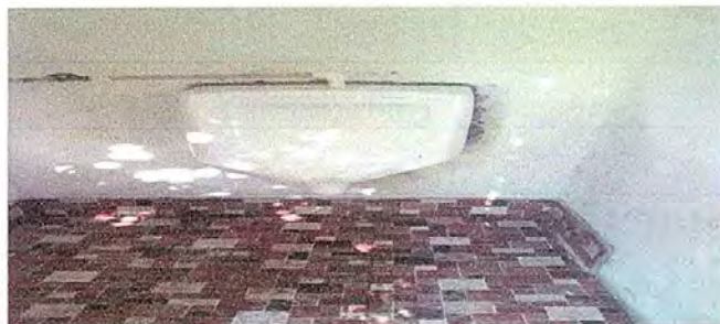
Foto 3: Modulo 1. Sustitucion de migitorio
