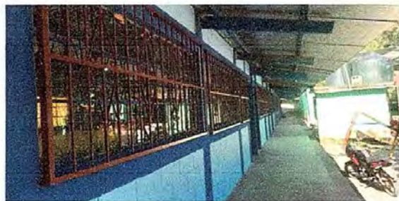
Foto 5: Modulo2. Suministro e instalacion de balcon de hierro en ventana
