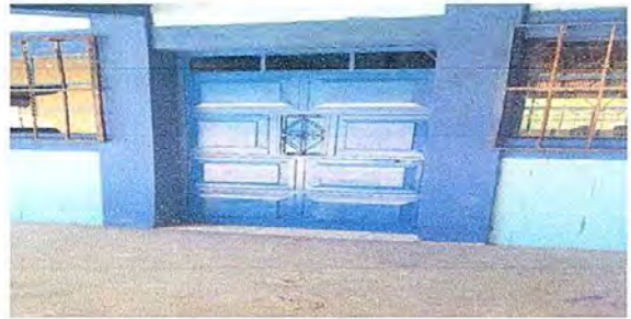
Foto 10: Modulo2. Mantenimiento a estructura de puerta (lijado, cambio de tubo, cepillado, lijeciones, aplicación de pintura)
