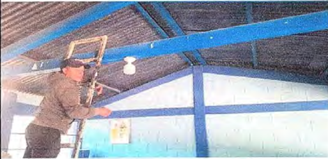
Foto 7: Modulo2. Sustitucion de focos ahorradores.
