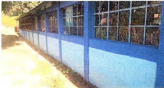
Foto 9: Modulo2. Pintura en muros exteriores e interiores.
