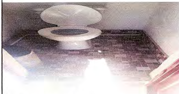
Foto 2: Modulo 1. Sustitucion Inodoro
