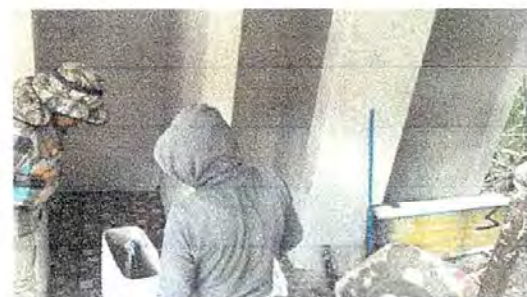
Foto 3:Modulo .1 .Sustitucion de Migitorio
