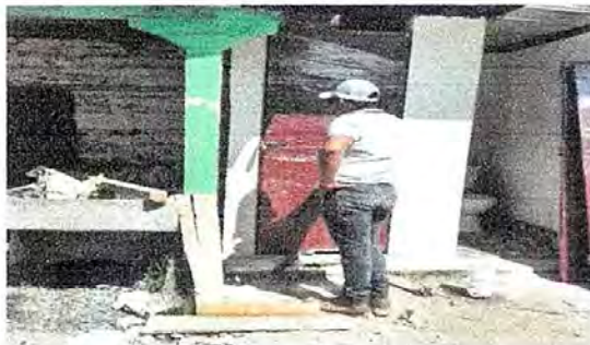
Foto1: Modulo 1. sustitucion puertas de metal en baños
