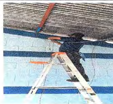
Foto 6:Modulo 2.Reparacion de cableado eléctrico.
