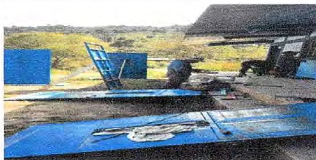
Foto 10:Modulo 2 Mantenimiento a estructura de puerta (lijado, cambio de tubo,sepillado ujeciones, aplicación de pintura)
