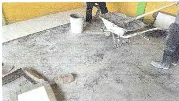
Foto 8: Modulo 2. sustitucion de piso de torta de concreto por piso cerámico.
