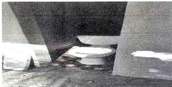
Foto 2: Modulo 1. .sustitucion inodoro
