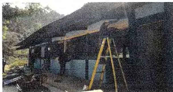
Foto 9:Modulo .2 Pintura en muros exteriores e interiores.
