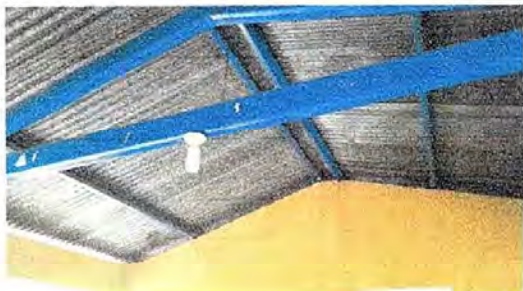
Foto 7: Modulo2. Sustitucion de focos ahorradores.
