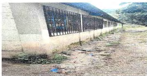
Foto 9: Modulo2. Pintura en muros exteriores e interiores.
