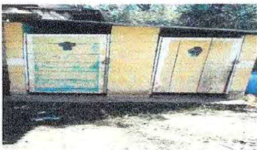
Foto 1: Modulo 1. Sustitucion puerta de metal en baños
