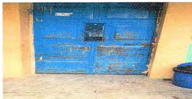
Foto 10: Modulo2. Mantenimiento a estructura de puerta (lijado, cambio de tubo, cepillado, sijecciones, aplicación de pintura)
