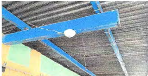
Foto 6: Modulo 2. Reparacion de cableado eléctrico.
