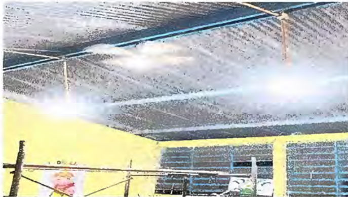
Foto 4: Modulo 1, 2 y 3: sustitución de lamparas, sustitución de acometida electrica en aulas
