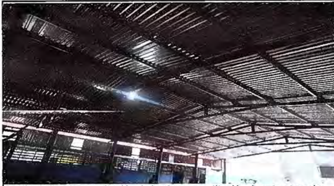
Foto 7: Modulo 5, sustitución de laminas y sustitución de estructura de soporte de madera por metal
