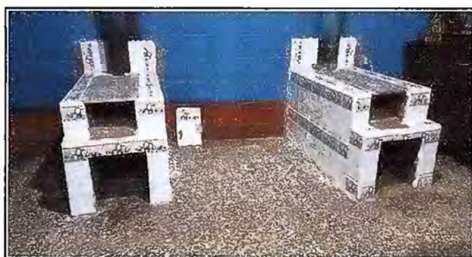
Foto 6: Modulo 4: instalación de azulejo en estufa rural
