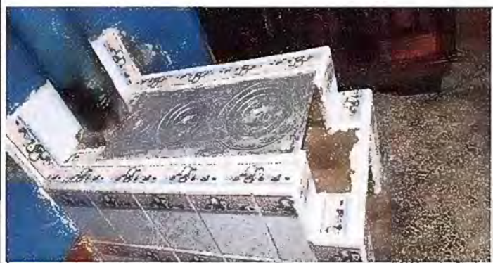
Foto 5: Modulo 4: sustitución de plancha de metal,
