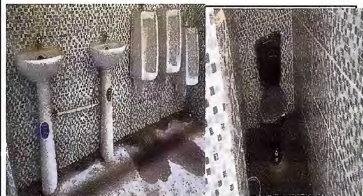
Foto 3: Modulo 1: Sustitución de mingitorio, lavamanos e inodoros.
