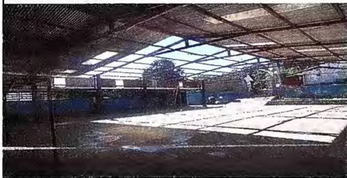
Foto 7: Sustitución de lamina
