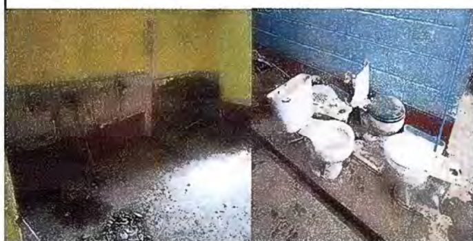
Foto 3: Modulo 1: Sustitución de mingitorio, lavamanos e inodoros.
