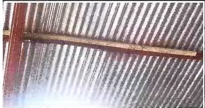
Foto 8: Modulo 5: sustitución de estructura de soporte de madera por metal
