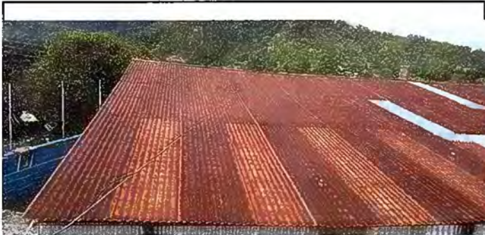
Foto 7: Modulo 5, sustitución de laminas y sustitución de estructura de soporte de madera por metal
