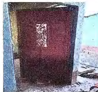
Foto 6: Mantenimiento de puerta de cocina
