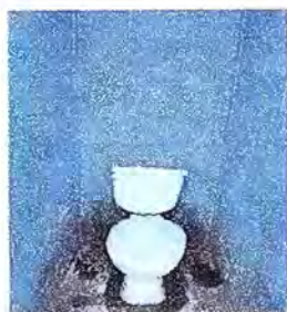
Foto 3: Sustrución de inodoros
