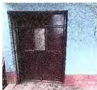
Foto 5: Mantenimiento de puerta de cocina
