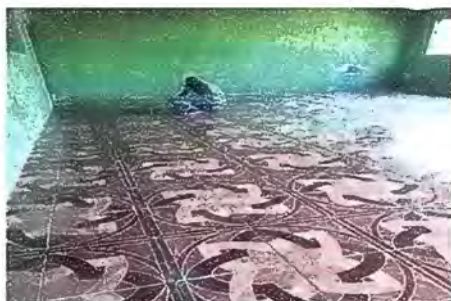
Foto 5: Reparación de piso de torta de concreto por piso cerámico
