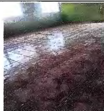
Foto 6: Reparación de piso de torta de concreto por piso cerámico
