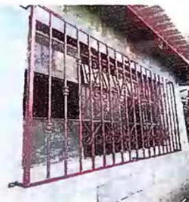
Foto 2: Sustitución e instalación de balcón de hierro en ventan de cocina
