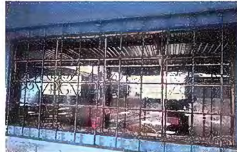
Foto 2: Mantenimiento de balcones de metal en aula
