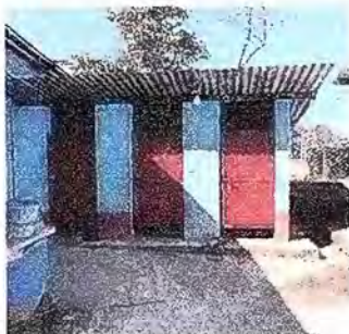
Foto1: Sustrución de puertas sanitaria
