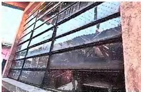
Foto 5: Sustitución de vidrios en alufas
