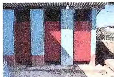
Foto 2: Sustrución de puertas sanitaria
