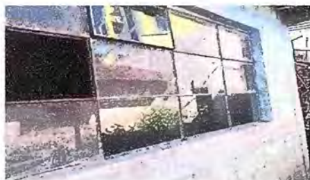
Foto 3: Sustitución de vidrios en cocina
