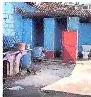
Foto 2: Sustitucion de puertas sanitaria
