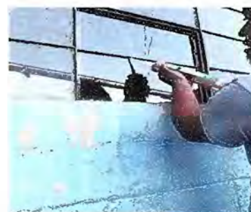
Foto 4: Sustitucion de vidrios en cocina
