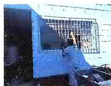
Foto 2: Sustitucion e instalacion de balcon de hierro en ventan de cocina
