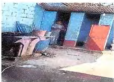
Foto1: Sustitucion de puertas sanitaria
