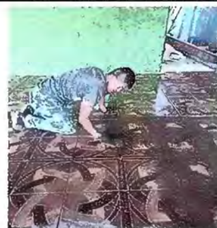
Foto 6: Reparación de piso de torta de concreto por piso ceramico
