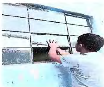
Foto 3: Sustitucion de vidrios en cocina
