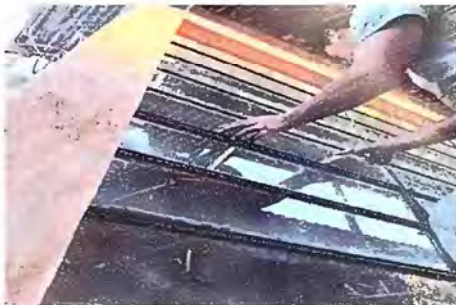
Foto 5: Sustitución de vidrios en alula
