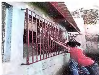
Foto1: Sustitucion e instalacion de balcon de hierro en ventan de cocina
