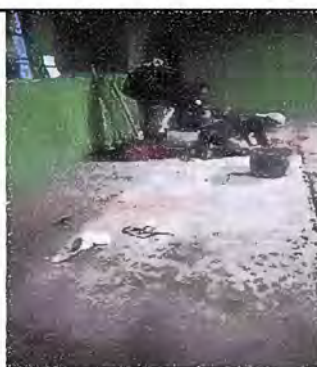
Foto 5: Reparación de piso de torta de concreto por piso ceramico
