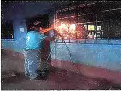
Foto 1: Mantenimiento de balcones de metal en aula
