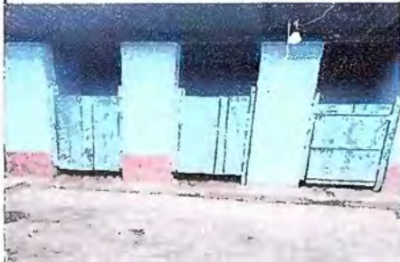
Foto1: Sustitucion de puertas sanitaria
