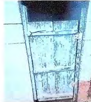
Foto 2: Sustitucion de puertas sanitaria
