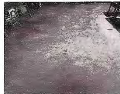
Foto 6: Reparación de piso de torta de concreto por piso ceramico
