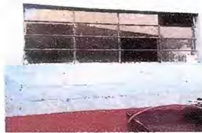
Foto 4: Sustitución de vidrios en ventearna
