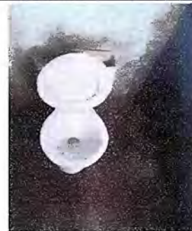
Foto 4: Sustitucion de inodoros
