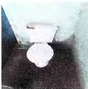
Foto 3: Sustitucion de inodoros
