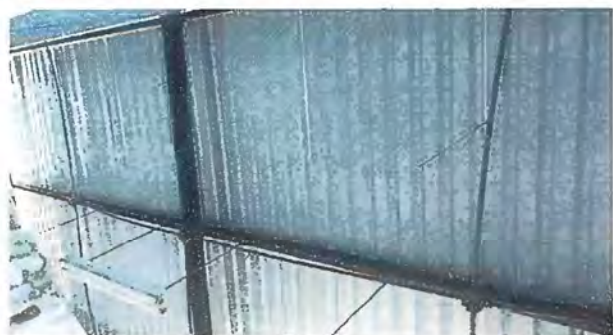
Foto 1: Modulo 1 Lamina troquelada colocada
