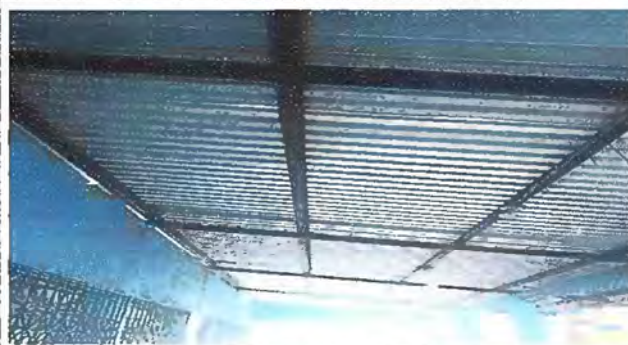
Foto 2: Modulo 1 Lamina troquelada colocada
