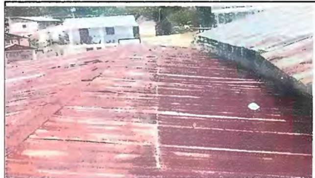
Módulo 3: Foto 4, Sustitución de láminas por láminas troqueladas
