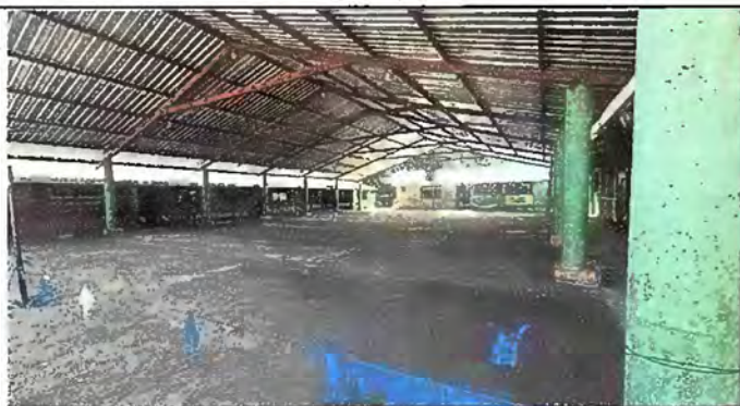
Foto1: Sustitución de Piso de Torta de Concreto
