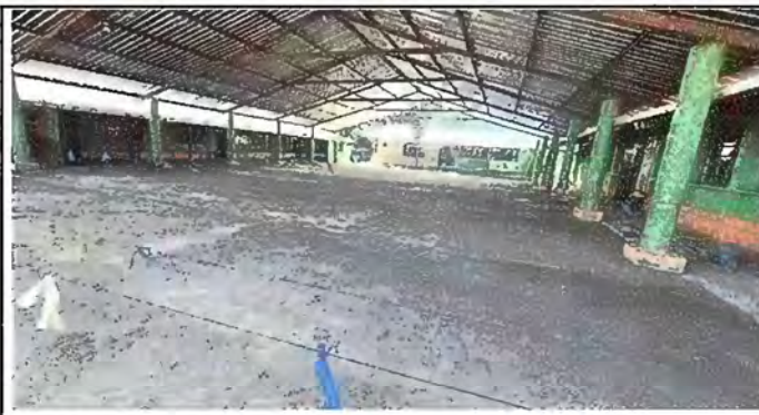
Foto 2: Sustitución de Piso de Torta de Concreto.
