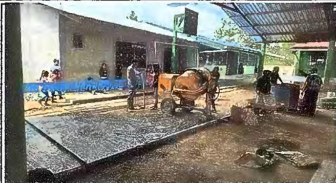
Foto1: Sustitución de Piso de Torta de Concreto
