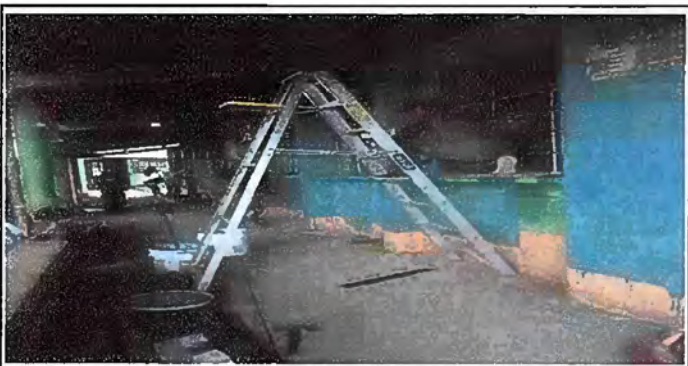
Foto 5: Pintura en Muros Exteriores e interiores
