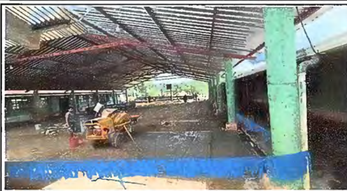
Foto 2: Sustitución de Piso de Torta de Concreto.
