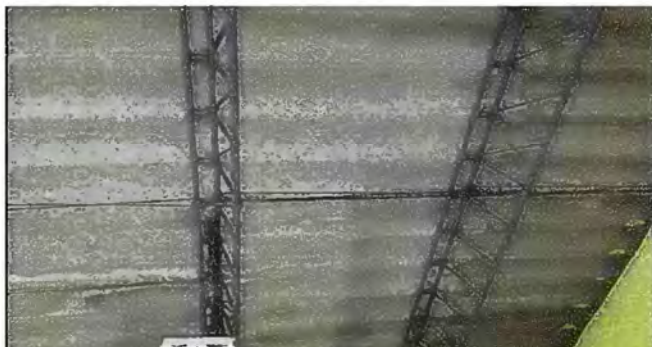
Foto 4: Módulo 2 Sustrucción de estructura de soporte de metal, por metal
