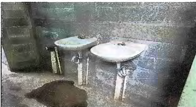
Foto 22: Módulo 5 Sustitución de lavamanos
