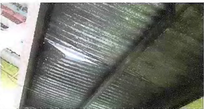
Foto 5: Módulo 3 Sustrucción de láminas, por láminas troquelada aluzinc calibre 26
