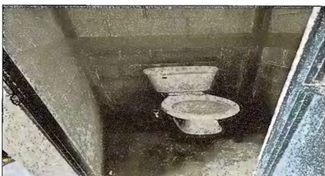
Foto 6: Módulo 5 Sustitución de inodoro
