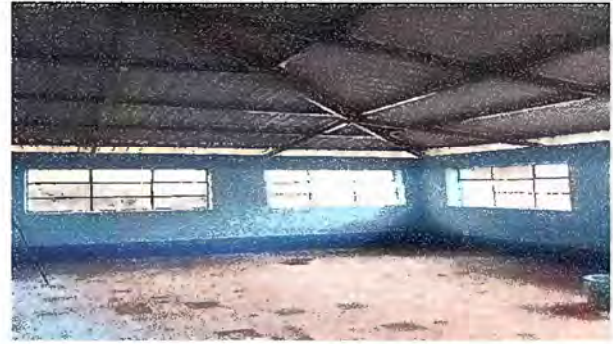
Foto 10: Modulo 2 Ya Finalizados los Trabajos a un 100% de la Sustitución de la Estructura de soporte de Madera por Soporte de Metal.
