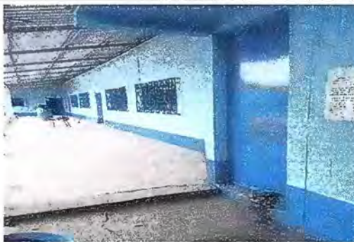
Foto 10: Modulo 2 Ya Finalizados los Trabajos a un 100% de la Sustitución de la Estructura de soporte de Madera por Soporte de Metal y pintura de muro exterior.
