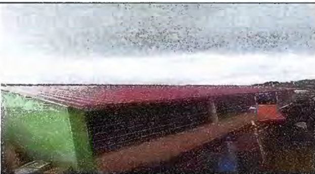
Foto 5: Modulo 3 En ejecución de los Trabajos de Sustitución de 123 M2 de lámina por Lámina Troquelada de Aluzinc.
