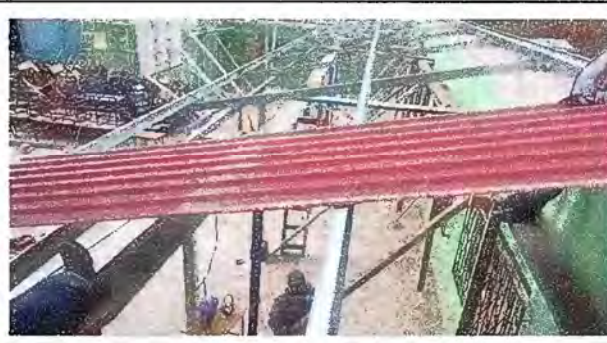
Foto 4: Modulo 2 Durante el Proceso de los Trabajos de la Sustitución de los Soporte de Madera por Soporte de Metal y colocación de lamina troquelada Aluzinc calibre 26.
