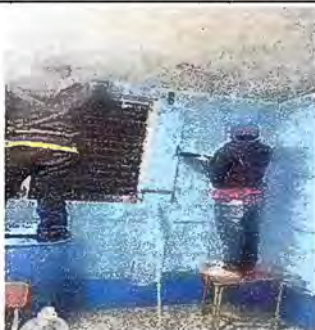
Foto7: Modulo 4 En Ejecución del Pintado de Muros interiores del modulo de sanitarios.
