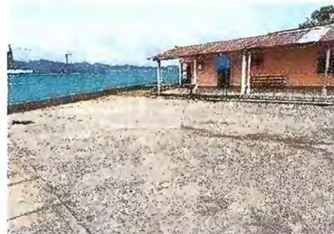
Foto 2: Cancha Reparación de planchas de concreto
