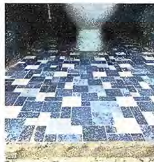
Foto 12: Módulo 3 Sustitución de piso de torta de concreto por piso cerámico antideslizante
