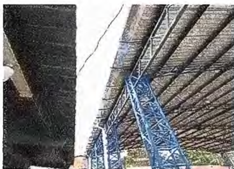
Foto 5: Módulo 2 Sustitución de Canal de metal
