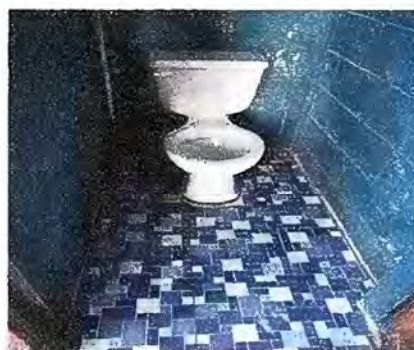
Foto 9: Módulo 3 Instalación de inodoro
