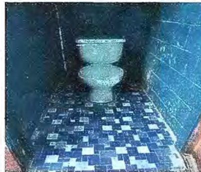
Foto 8 : Módulo 3 Sustitución de inodoro
