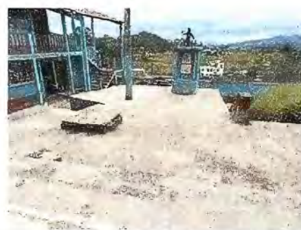
Foto 4: Patio Reparación de planchas de concreto
