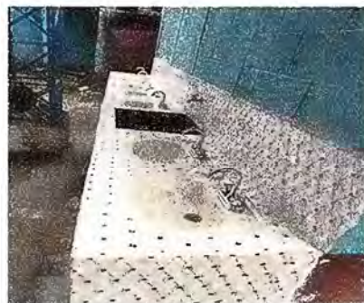
Foto 10: Módulo 3 Sustitución lavamanos
