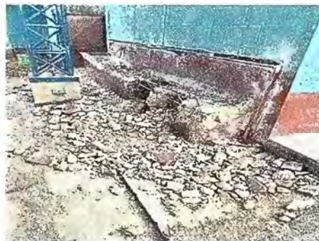
Foto 10: Módulo 3 Sustitución lavamanos
