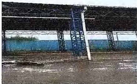
Foto 7 : Módulo 2 Reparación de bajada de agua pluvial tubo PVC 3"
