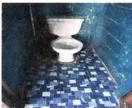
Foto 9: Módulo 3 Instalación de inodoro
