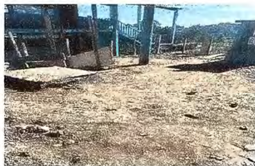
Foto 4: Patio Reparación de planchas de concreto
