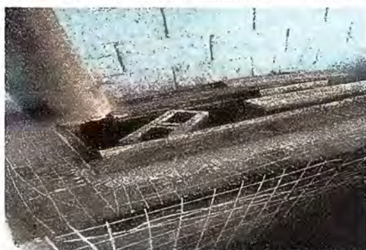
Foto 3: Módulo 1 Sustitución de plancha de metal de tres hornillas y suministro e instalación de azulejo en estufa rural
