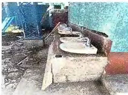
Foto 11: Módulo 3 Instalación de lavamanos
