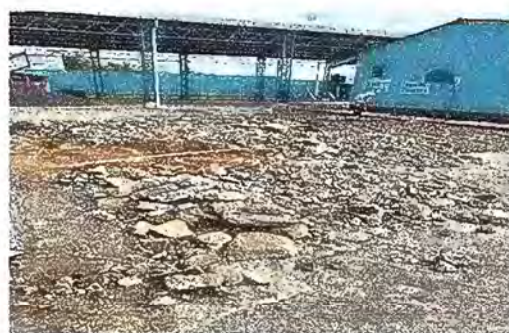
Foto 2: Cancha Reparación de planchas de concreto
