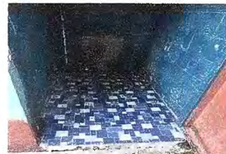
Foto 12: Módulo 3 Sustitución de piso de torta de concreto por piso cerámico antideslizante
