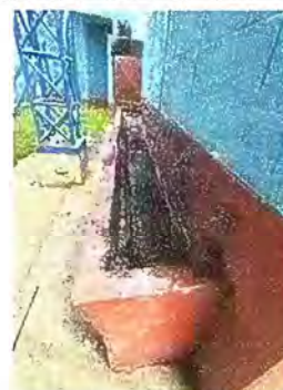
Foto 10: Módulo 3 Sustitución lavamanos
