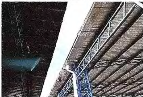
Foto 7 : Módulo 2 Reparación de bajada de agua pluvial tubo PVC 3"
