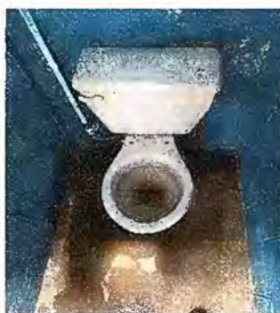
Foto 9: Módulo 3 Instalación de inodoro
