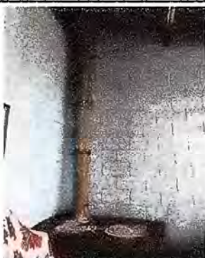
Foto 3: Módulo 1 Sustitución de plancha de metal de tres hornillas y suministro e instalación de azulejo en estufa rural
