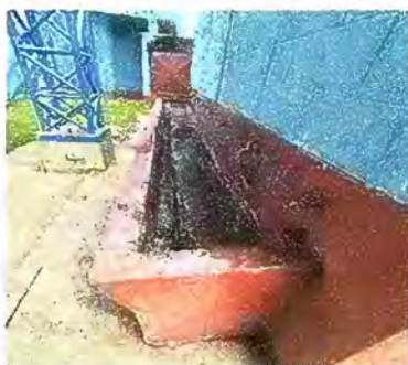
Foto 11: Módulo 3 Instalación de lavamanos
