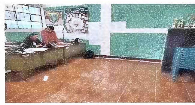
Foto 10: Sustitución de piso de concreto por ceramico
