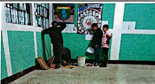
Foto 5: Sustrucción de concreto por piso ceramico
