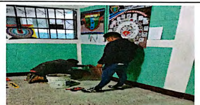
Foto 6: Sustrucción de concreto por piso ceramico
