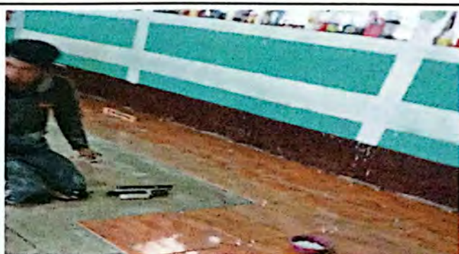
Foto 4: Sustrucción de concreto por piso ceramico
