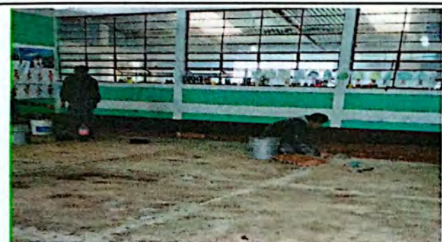
Foto 3: Sustrucción de concreto por piso ceramico
