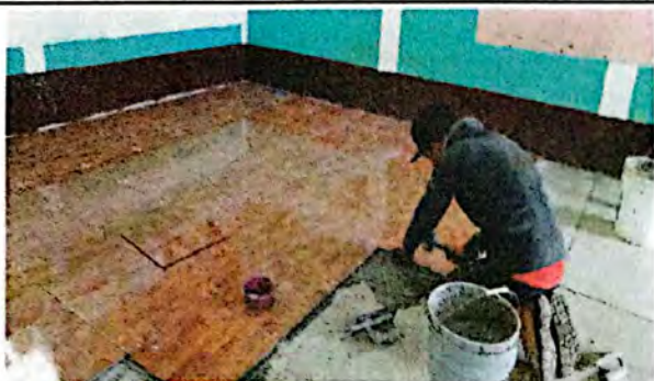
Foto 7: Sustitución de concreto por piso ceramico
