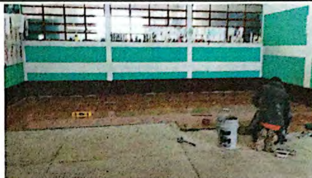
Foto 8: Sustitución de concreto por piso ceramico
