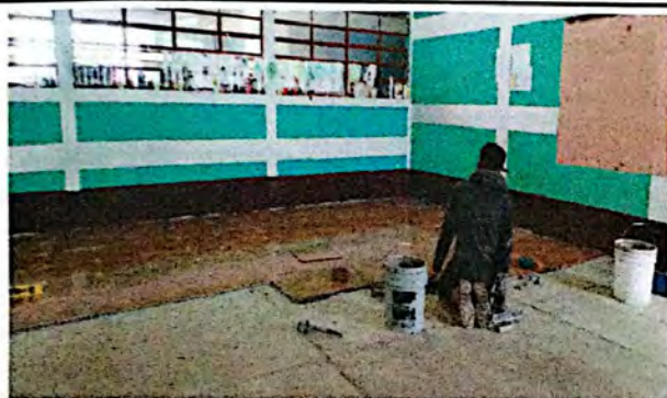
Foto 9: Sustitución de concreto por piso ceramico
