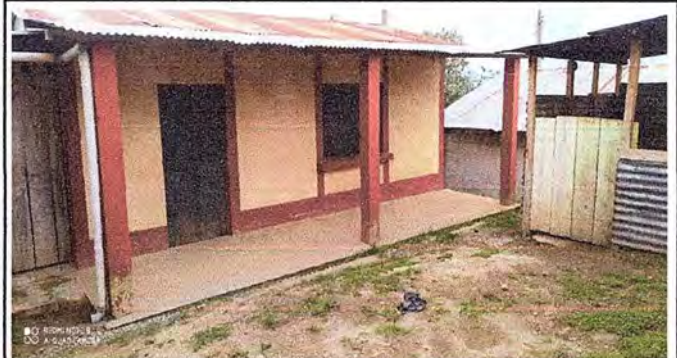
Modulo 5: Colocacion de azulejo
