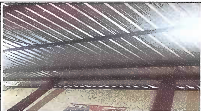
Foto1: Sustitución de laminas
