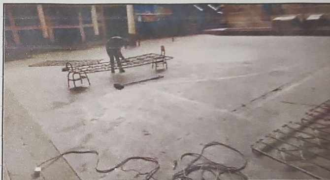
Foto 4: Sustitución de balcones
