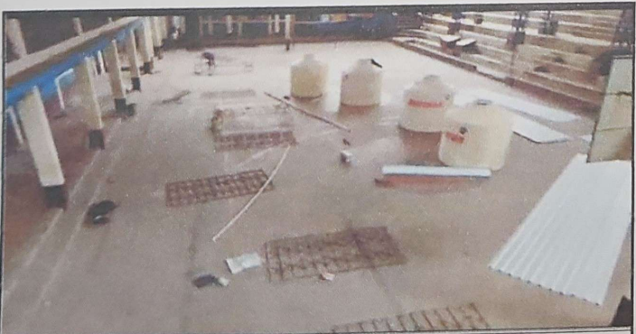
Foto 5: Sustitución de tinacas
