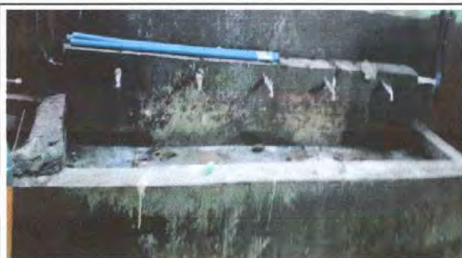
Foto 3, Modulo 2: sustitución de chorros
