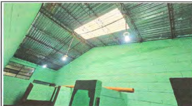
Foto 4, Modulo 2: Sustitución de focos ahorradores
