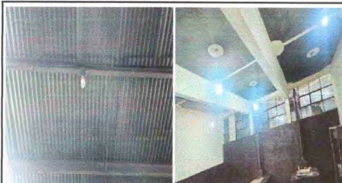
Foto 13, Modulo 1: sustitución de focos ahorradores
