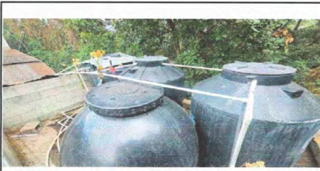
Foto 18, Modulo 2: Sustitución de depósito de agua 2500 lt
