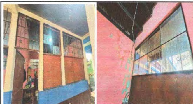
Foto 8, Módulo 1: Sustitución de vidrios
