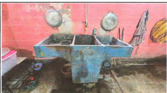
Foto 9: Módulo 1 sustición de lavadero de concreto grande
