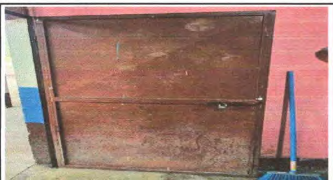
Foto 11, Módulo 1: Mantenimiento a estructura de puerta (lijado, cambio de tubo, cepillado, sujeciones, aplicación de pintura)
