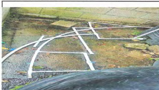
Foto 1, Modulo 2: sustitucion de tuberia de línea principal
