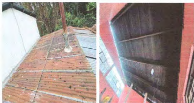
Foto 7 Módulo 1: sustitución de lamina por lamina troquelada aluzinc cal. 26
