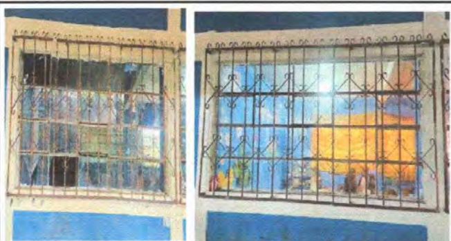
Foto 5, Modulo 3: sustitución vidrios
