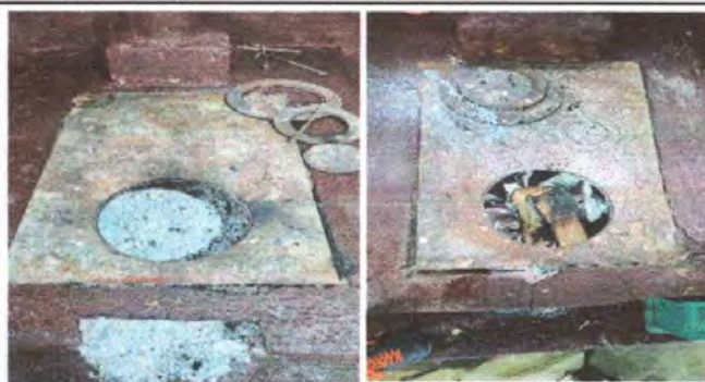
Foto 10, Módulo 1: Sustitución de plancha de metal de 4 hornillas
