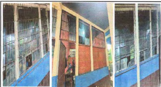
Foto 15, Modulo 1: Mantenimiento a balcones de metal.
