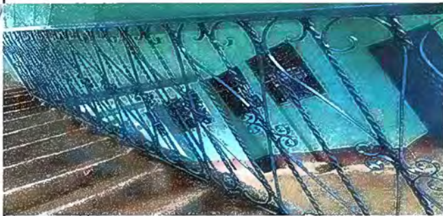
Foto 11: MODULO 3: mantenimiento de barrandas de metal
