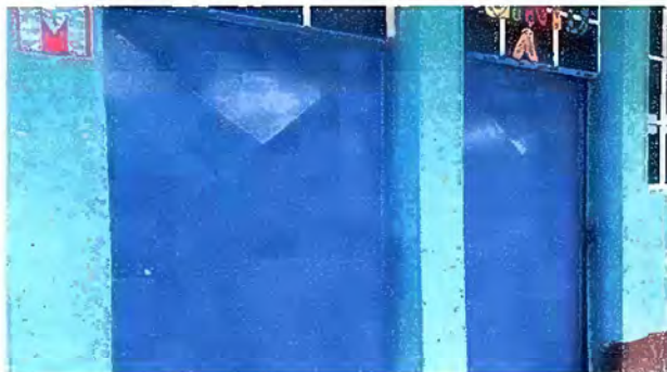
Foto 13: MODULO 4: mantenimiento a estructura de puertas
