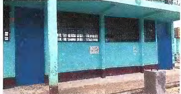
Foto 6: MODULO 2: mantenimiento a estructura de puertas
