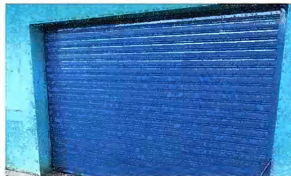
Foto 14: MODULO 5: Mantenimiento estructura de puertas (perchinas)
