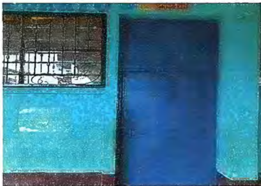
Foto 9: MODULO 3: Mantenimiento a estructura de puertas
