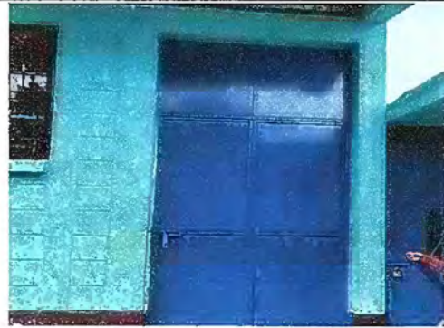
Foto 2: MODULO 1: Mantenimiento a estructura de puertas
