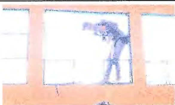
Foto 3: MODULO 1: Mantenimiento a estructura de metal en ventanas y sustitución de vidrios
