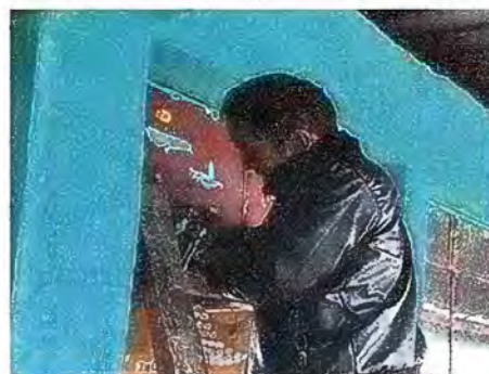
Foto 6: MODULO 2: mantenimiento a estructura de puertas
