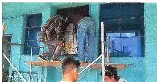
Foto 12: MODULO 4 : suministro e instalación de balcon de hierro en ventanas
