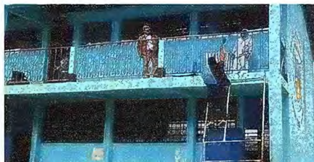
Foto 8: MODULO 2: Mantenimiento de barrandas de metal
