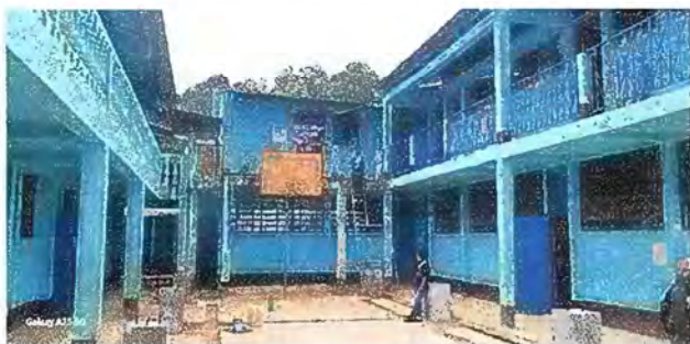
Foto 11: MODULO 3: mantenimiento de barrandas de metal
