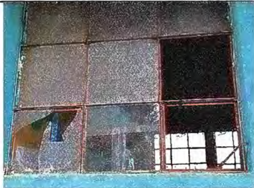
Foto 3: MODULO 1 Mantenimiento a estructura de metal de ventanas y sustitución de vidrios
