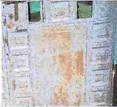
Foto 13: MODULO 4. Mantenimineto a estructura de puertas
