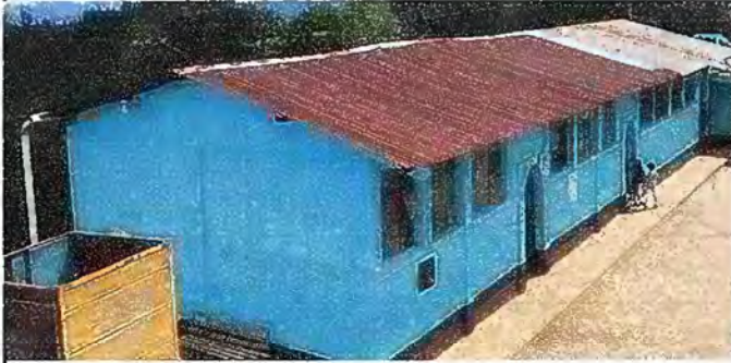
Foto 1: MODULO 1. Sustitución de láminas por laminas troqueladas calibre 26.
