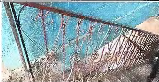
Foto 11: MODULO 3. Mantenimiento de barandas de metal
