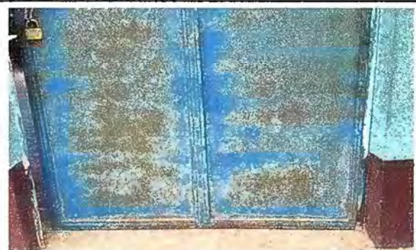
Foto 6: MODULO 2. Mantenimiento a estructura de puertas
