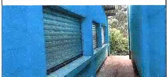
Foto 14: MODULO 5. Mantenimiento a estructura de puestas(percianas)
