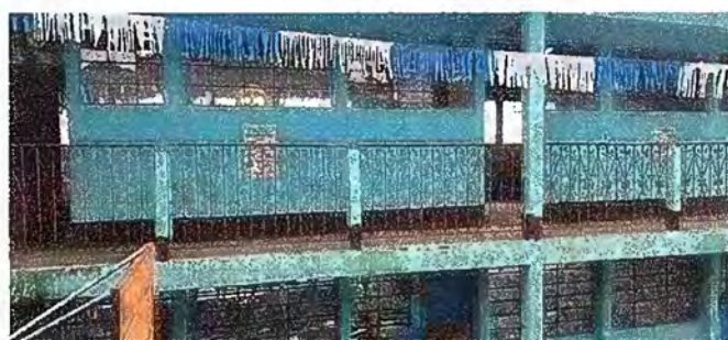
Foto 8: MODULO 2. Mantenimiento de barandas de metal
