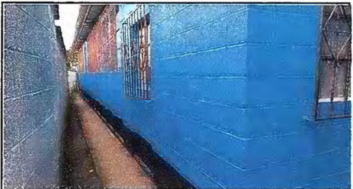
Foto 28: Pintura de muros interiores y exteriores
