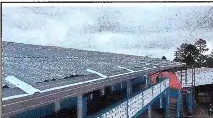
Foto 3: Modulo 1 Sustitución de canal de metal
