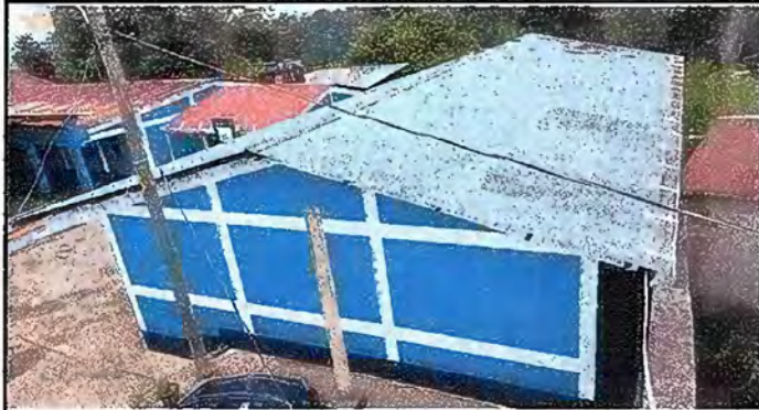
Foto 25: Modulo 9 Sustitución de canal de metal
