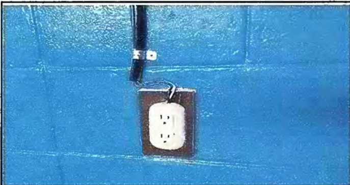
Foto 5: Modulo 2 Reparación cableado eléctrico
