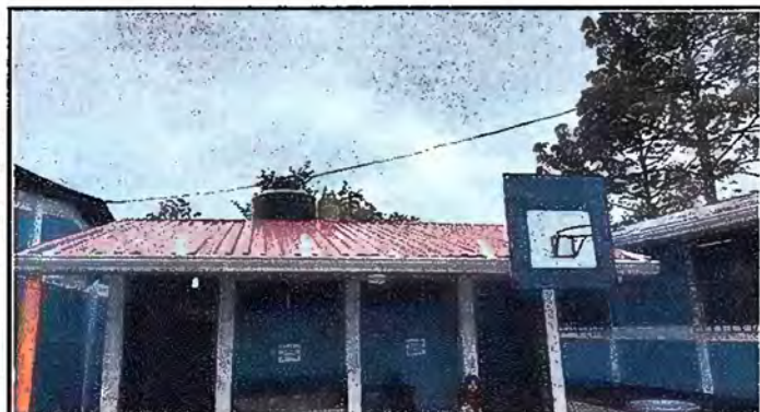
Foto 21: Modulo 8 Sustitucion de canal de metal
