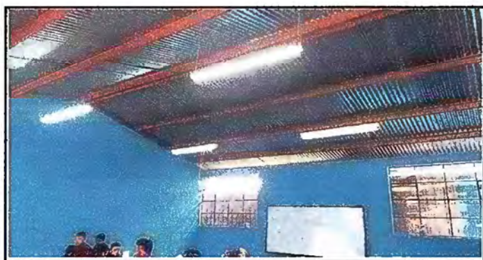
Foto 23: Modulo 9 Sustitucion de lamparas
