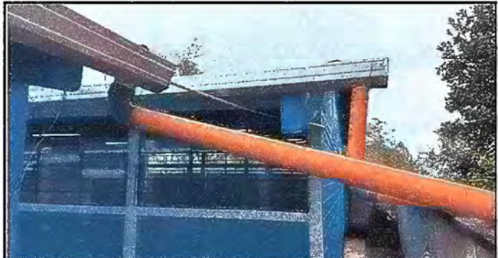
Foto 18: Modulo 6 Sustitución de canal de metal
