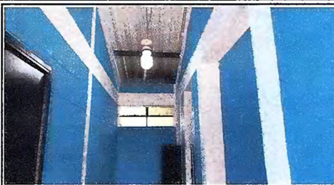
Foto 20: Modulo 8 sustitucion de lamparas
