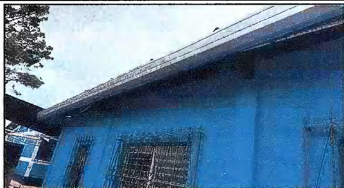
Foto 19: Modulo 7 Sustitucion de canal de metal
