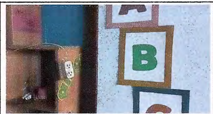
Foto 5: Modulo 2 Reparación cableado electrico (En proceso)
