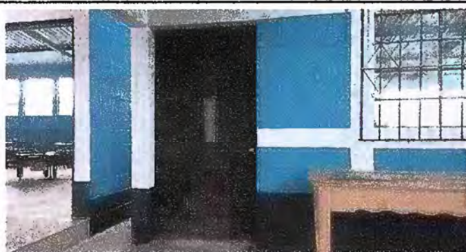
Foto 9: Modulo 3 Matenimiento de puertas (En Proceso)
