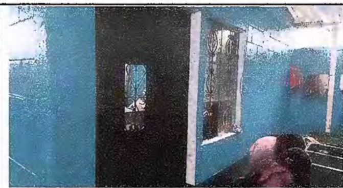
Foto 12: Modulo 4 Matenimiento de puertas (En Proceso)
