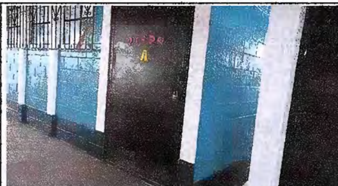
Foto 6: Modulo 2 Mantenimiento de puertas (En Proceso)
