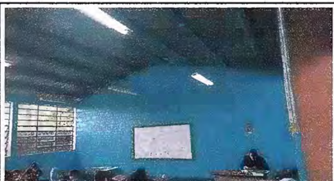
Foto 16: Modulo 6 Situación de lamparas (En proceso)
