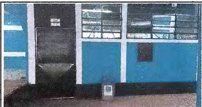
Foto 17: Modulo 6 Mantenimiento de puertas (En proceso)
