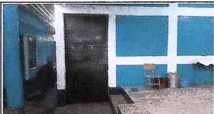
Foto 15: Modulo 5 Mantenimiento de puertas (En proceso)
