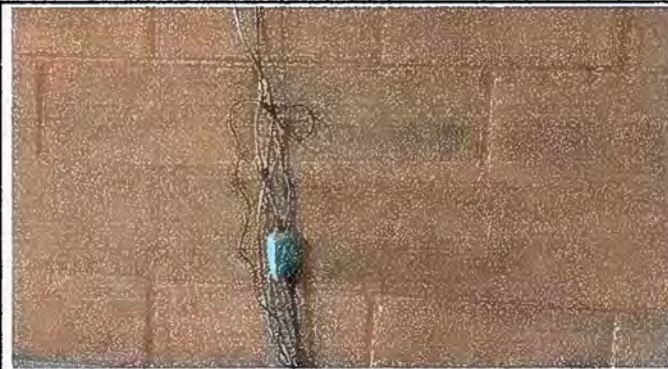
Foto 14: Modulo 5 Reparación cableado electrico
