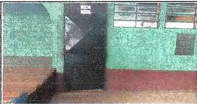
Foto 17: Modulo 6 Matenimiento de puertas
