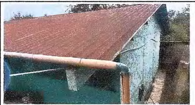
Foto 18: Modulo 6 Sustitución de canal de metal
