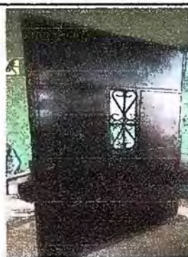
Foto 12: Modulo 4 Mantenimiento de puertas
