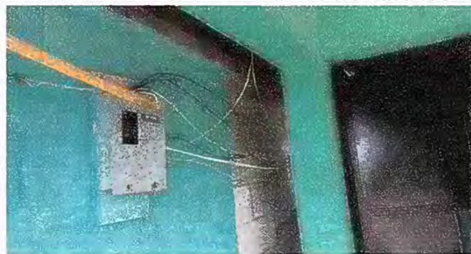
Foto 2: Modulo 1 Reparación cableado electrico
