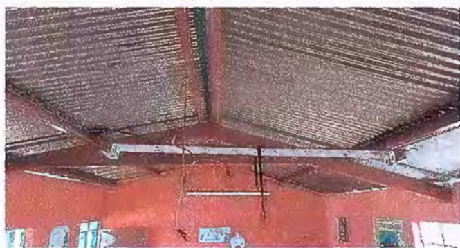
Foto 1: Modulo 1 Situación de lamparas
