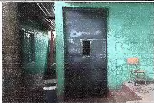
Foto 15: Modulo 5 Matenimiento de puertas
