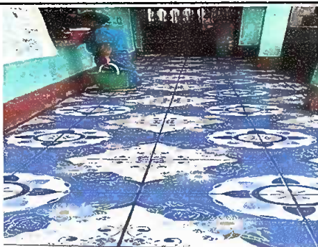
Módulo 3: Sustitución de piso en la cocina
