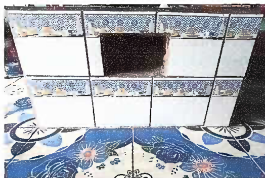
Módulo 3: Sustitución de azulejo
