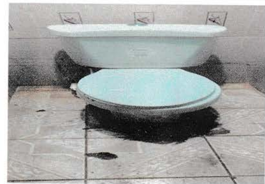
Módulo 2: Sustitución de 5 inodoro
