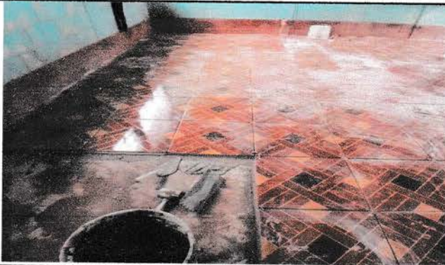
Módulo 2: Sustitución de piso en la Dirección
