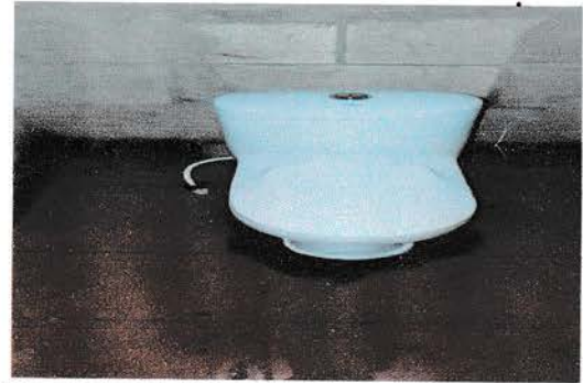
Módulo 1: Sustitución de 6 inodoro
