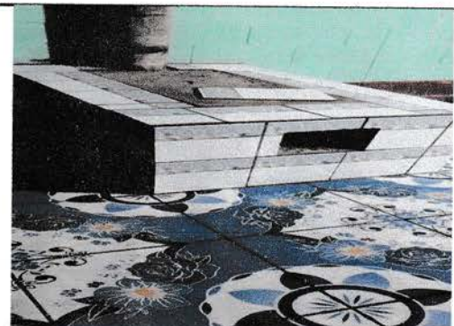
Módulo 3: Sustitución de azulejo
