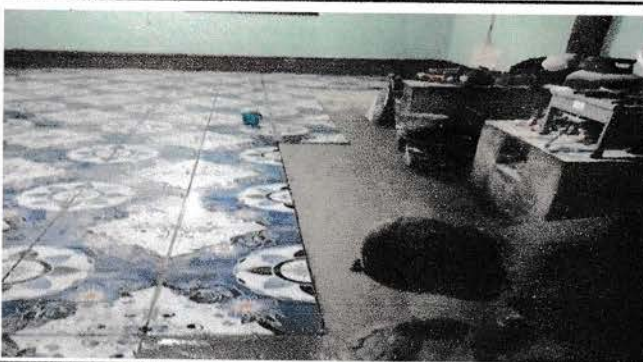
Módulo 3: Sustitución de piso en la cocina
