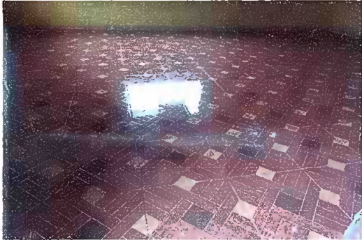
Foto 7: Módulo 3: Sustitución de piso de torta de concreto
