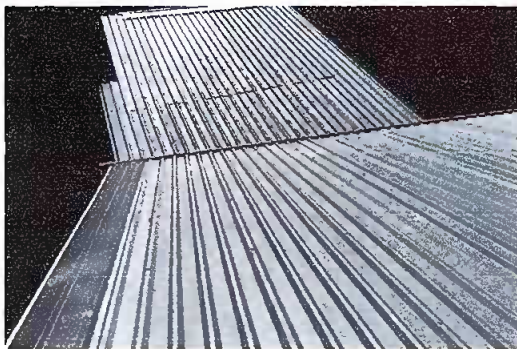
Foto 9: Módulo 3 sustitución de lámina, por lámina troquelada aluzinc calibre 26, sustitución de capote de lámina por lámina troquelada, sustitución de elementos de fijación (tornillos)
