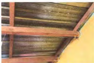
Foto 3. Modulo 1 : sustrucción de lámina, por lámina troquelada aluzinc calibre 26, sustrucción de capote de lámina por lámina troquelada, sustrucción de elementos de fijación (tornillos), sustrucción de soporte de
