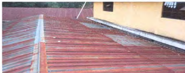
Foto 2. Modulo 1 : sustrucción de lámina, por lámina troquelada aluzinc calibre 26, sustrucción de capote de lámina por lámina troquelada, sustrucción de elementos de fijación (tornillos)
