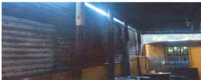
Foto 15. Muro Perimetral: Reparación Muro Perimetral
