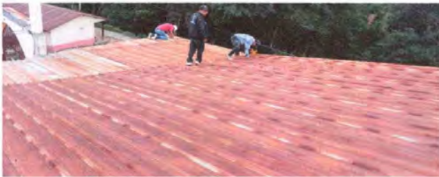
Foto 9. Modulo 3 : sustrución de lámina, por lámina troquelada aluzinc calibre 26, sustrución de capote de lámina por lámina troquelada, sustrución de elementos de fijación (tornillos)
