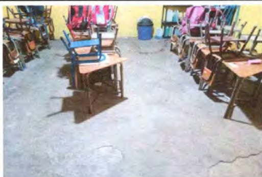
Foto 5. Modulo 1: Sustrucción de piso de piso de torta de concreto
