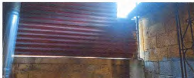
Foto 14. Muro Perimetral: Reparación Muro Perimetral
