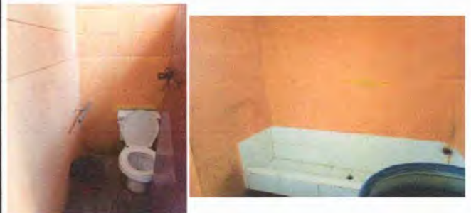
Foto 12. Modulo 4 (baños): sustrución de azulejos
