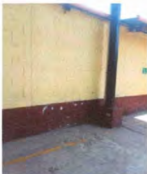
Foto 13. Pintura: Muros exteriores e interiores
