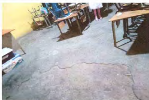
Foto 4. Modulo 1: Sustrucción de piso de piso de torta de concreto
