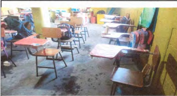
Foto 7. Modulo 3: Sustrución de piso de piso de torta de concreto
