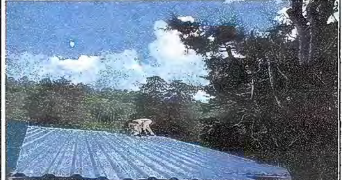
Foto 2: MODULO 1 SUSTITUCIÓN DE CAPOTE DE LAMINA PARA LAMINA TROQUELADA
