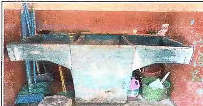
Foto 6: MODULO 1 SUSTITUCIÓN DE PILA
