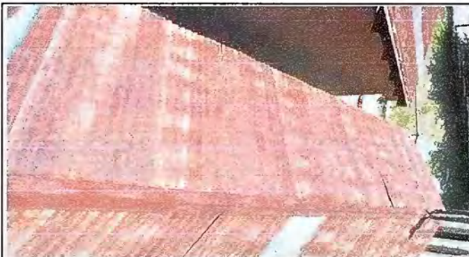
Foto 2: MODULO 1 SUSTITUCIÓN DE CAPOTE DE LAMINA PARA LAMINA TROQUELADA
