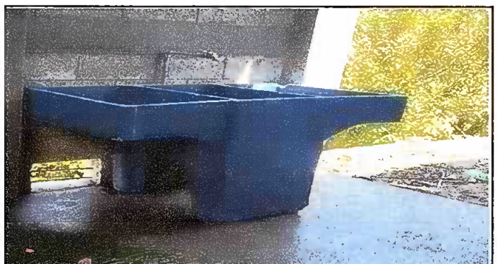
Foto 4: Modulo 5: Sustitución de pila de concreto
