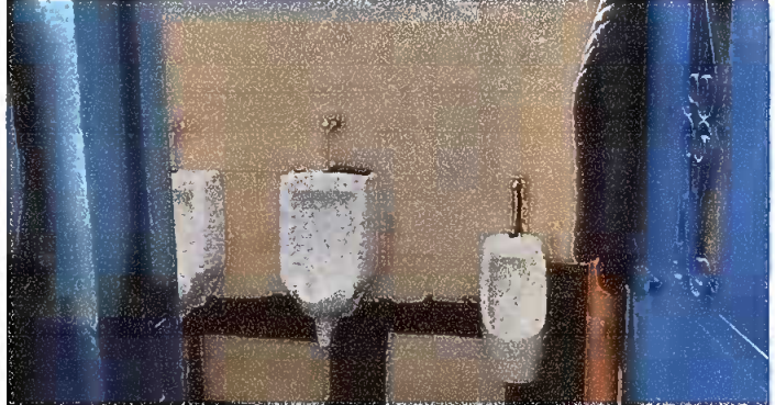
Foto 6: Modulo 5: Reparación de pared de sanitarios y susitución de mingitorios.
