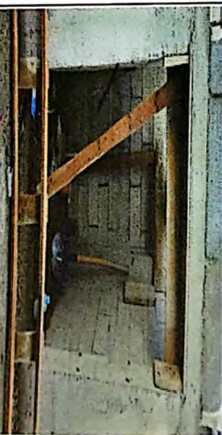
Foto 4: Módulo 5: reconstrucción de sanitario
