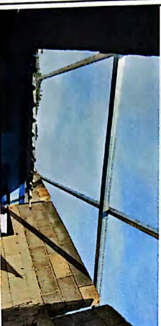
Foto 3: Módulo 5: Instalación de estructura mangloritos
