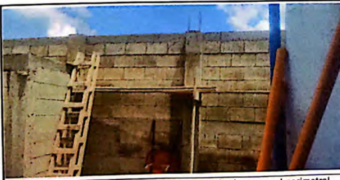
Foto 5: Modulo 5: Reparación de pared de sanitarios y pared perimetral
