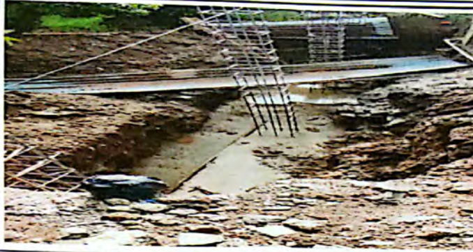
Foto 1: Modulo 5: Reparación de muro de contención
