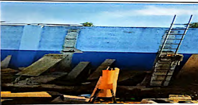
Foto 3: Modulo 5: Reparación de pared de sanitarios
