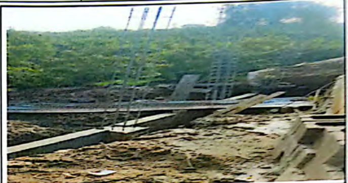
Foto 2: Modulo 5: Reparación de muro de contención
