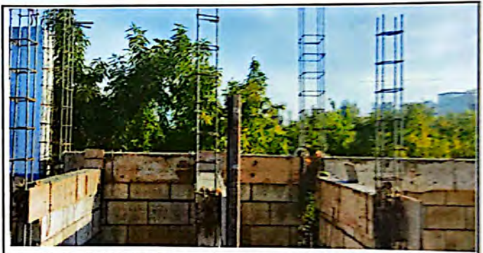
Foto 4: Modulo 5: Reparación de pared de sanitarios
