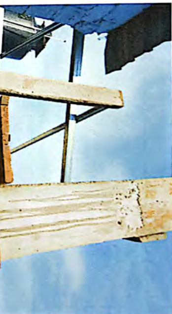
Foto 2: Módulo 5: Instalación de estructura portante de metal
