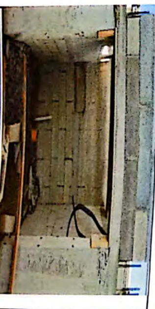
Foto 6: Módulo 5: Instalacion de tubería de agua y drenaje en servicios sanitarios
