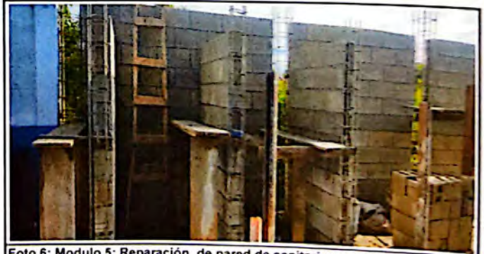
Foto 6: Modulo 5: Reparación de pared de sanitarios y pared perimetral
