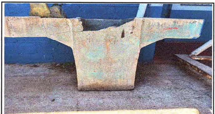
Foto 4: Modulo 5: Sustitución de pila de concreto de 2 lavaderos.
