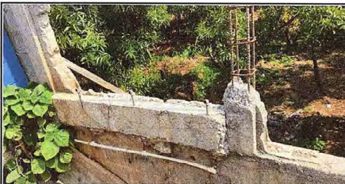
Foto 5: Modulo 5: reparacion de muro de contención
