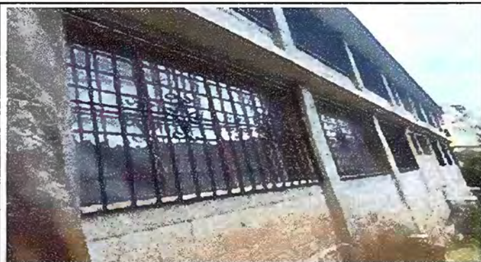
Foto 7: Modulo 3 Suministro e instalación de balcones de hierro en ventanas
