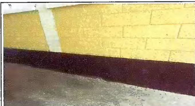
Foto 15 Modulo 5 Pintura en muros exteriores
