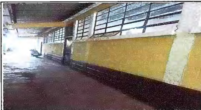
Foto 16 Pintura General: Pinturas en muros exteriores
