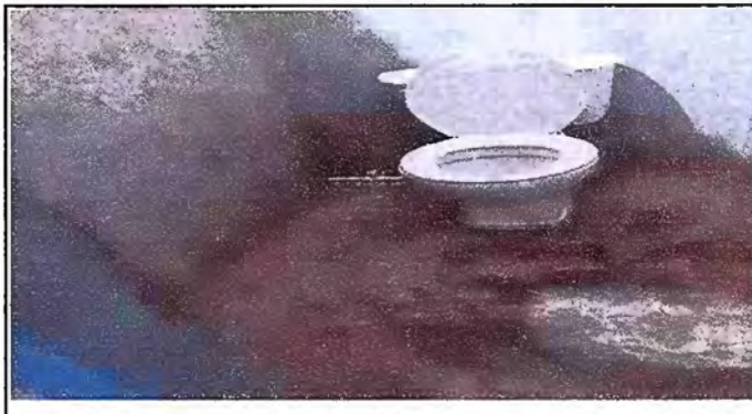
Foto 14 Modulo 5 Sustitucion de inodoro
