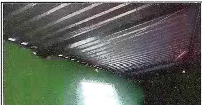
Foto 15 Modulo 5 Reparacion de cableado electrico
