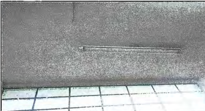
Foto 2 Modulo 1 : Sustitucion focos ahorradores
