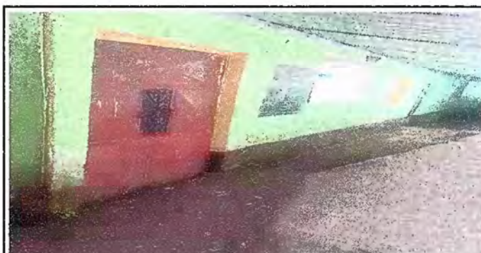
Foto 18 Pintura Genral: Pintura en muros exteriores
