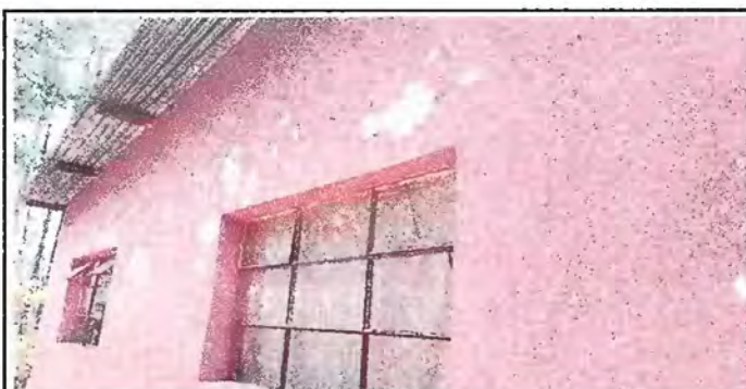
Foto 17 Pintura General: Pintura en muros exteriores
