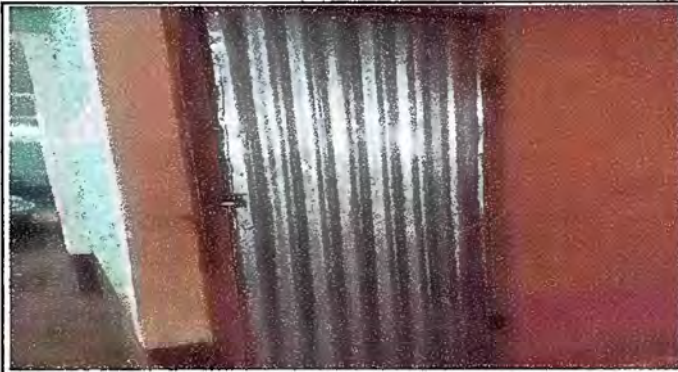
Foto 8 Modulo 3 Sustitucion de puerta
