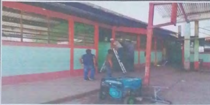
Foto1: MODULO 1: Sustitución de puerta de metal.
