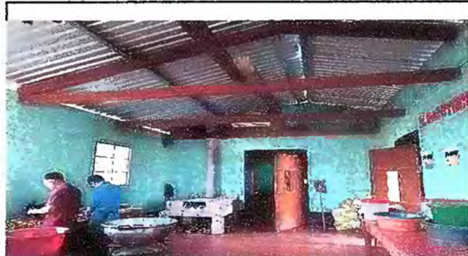
Foto 3: Módulo 2: sustitución de lámina troqueada alucinc calibre 26,sustitución de elementos de fijación(tornillos), sustitución de capotés, sustitución de chimenea de concreto
