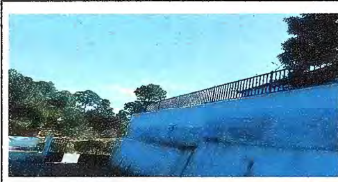
Foto 4: Módulo 3: Sustitución de Barrandas
