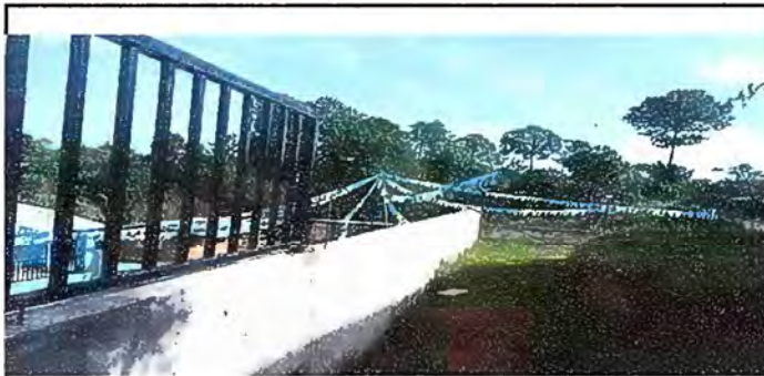
Foto 4: Modulo 3 Sustitución de Barrandas
