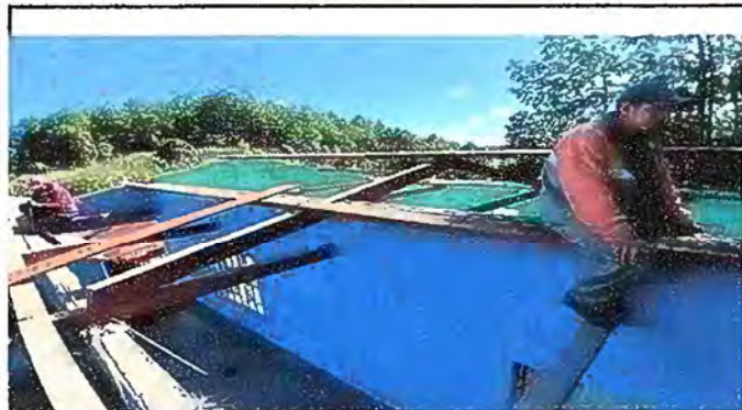
Foto 3: Módulo 2: sustitución de lámina troqueada alucínc calibre 26, sustitución de elementos de fijación (tornillos), sustitución de capotés
