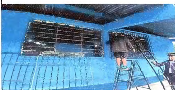
Foto 2: Modulo 1: suministro e instalación de balcon en ventana
