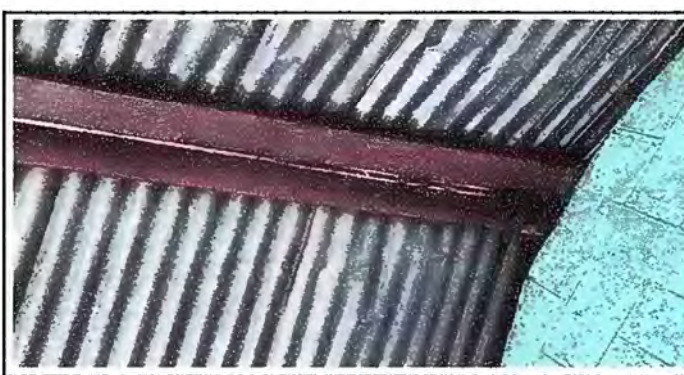
Foto 6. Módulo 2: sustitucion de estructura de soporte de madera por metal.
