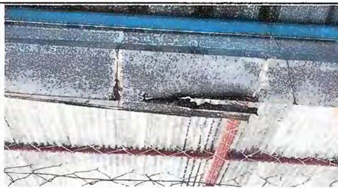
Foto 8. Módulo 4: Sustitución de canales de metal
