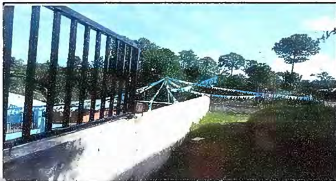
Foto 7. Módulo 3: Sustitución de Barrandas
