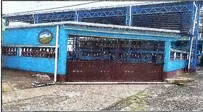
Foto 7: Sustitución de Portón de Metal
