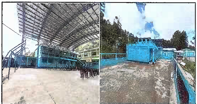
Foto 6: Pintura en muros exteriores e interiores
