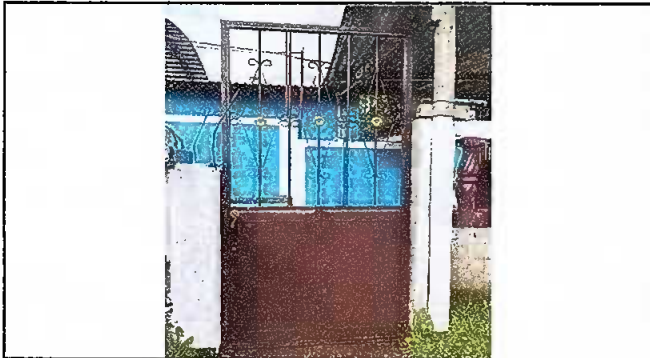
Foto 9: Sustitución de Puerta de Metal
