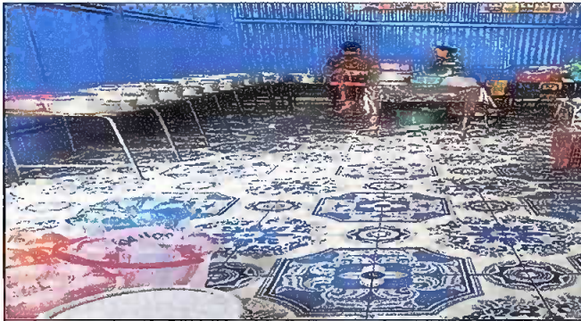
Foto1: Sustitución de Piso cerámico
