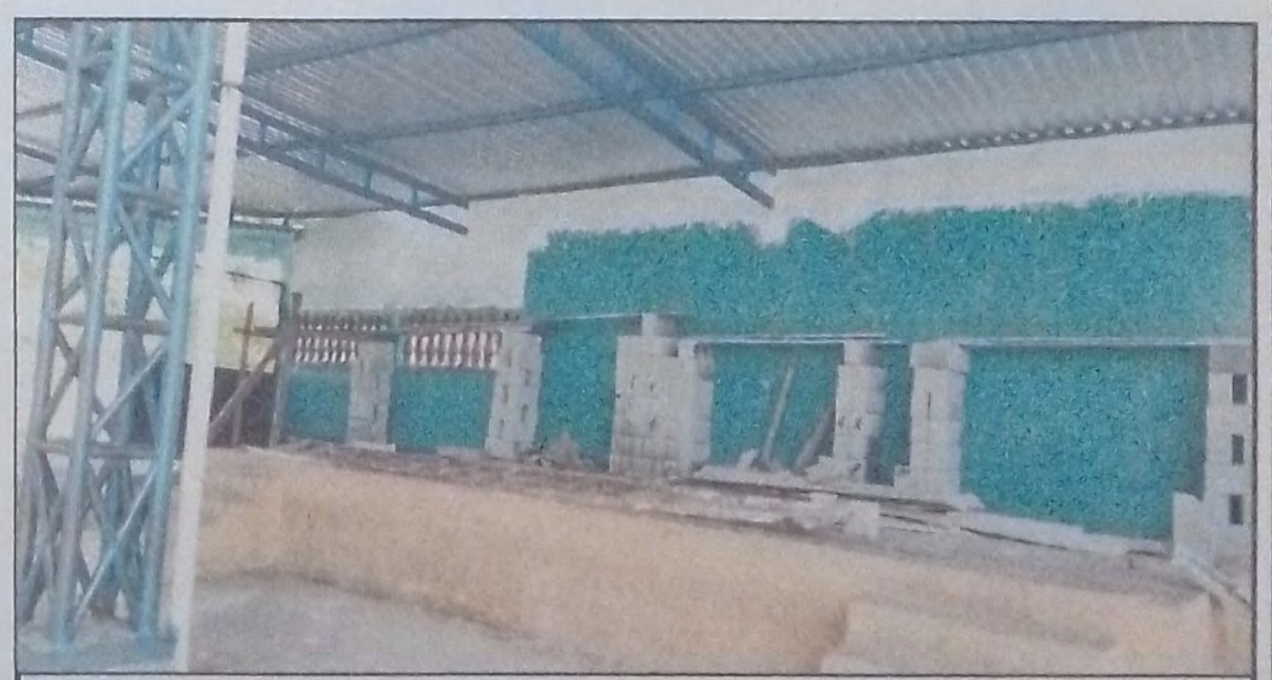
Foto 6 MURO PERIMETRAL : Reparacion de muro perimetral
