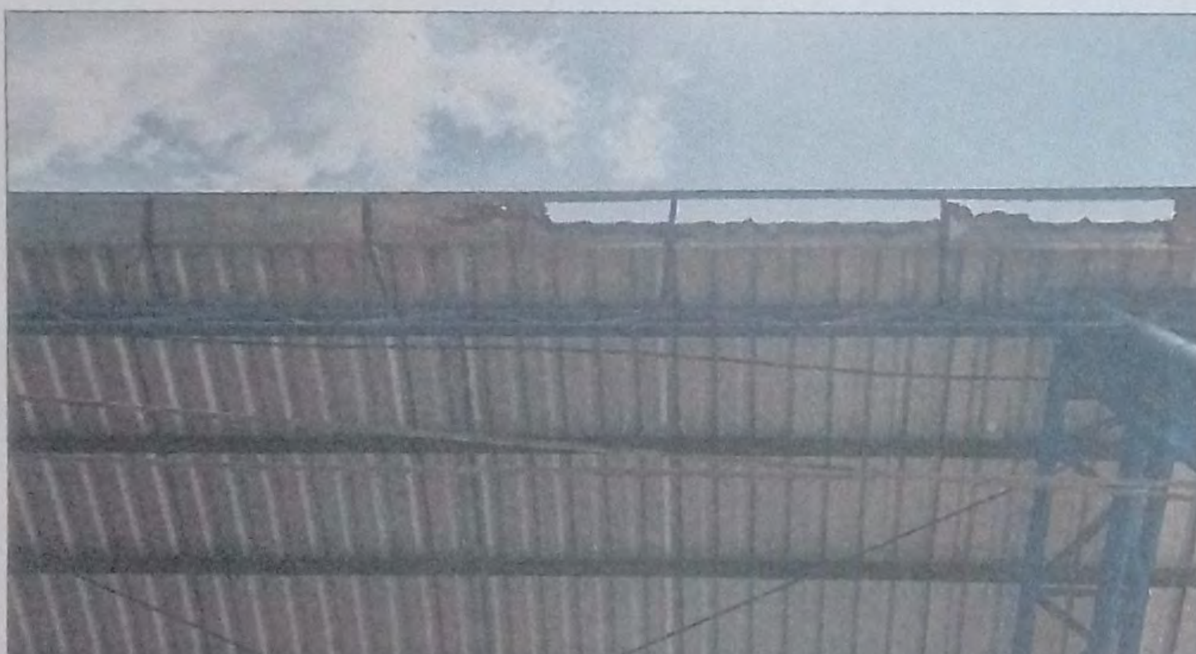
Foto 3: Sustitución de canales
