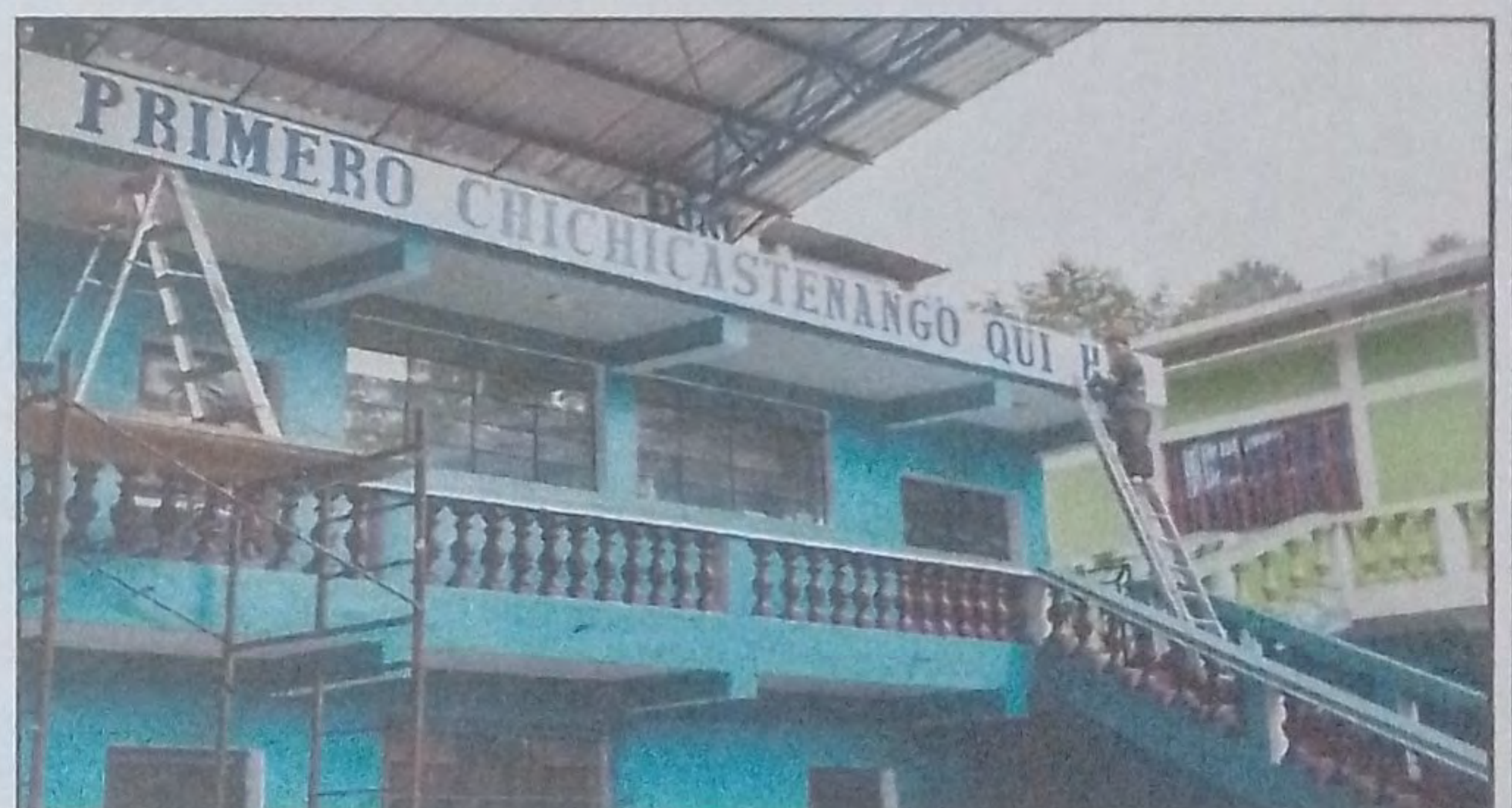
Foto 4: Pintura de exterior e interior general
