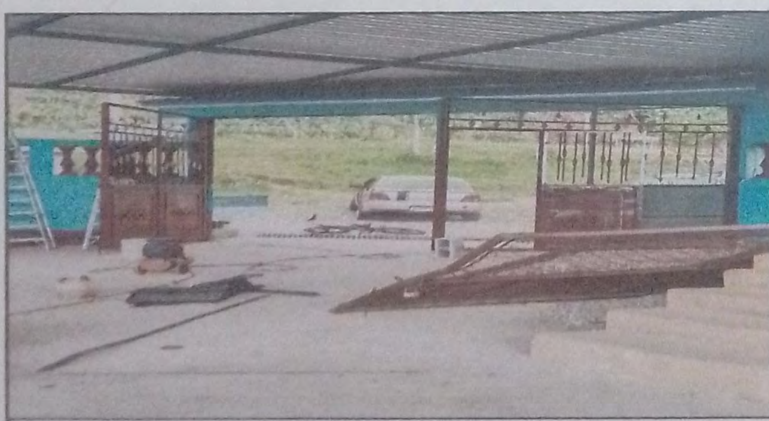
Foto 5: Sustitución de porton de metal, y sustitución de puerta de metal
