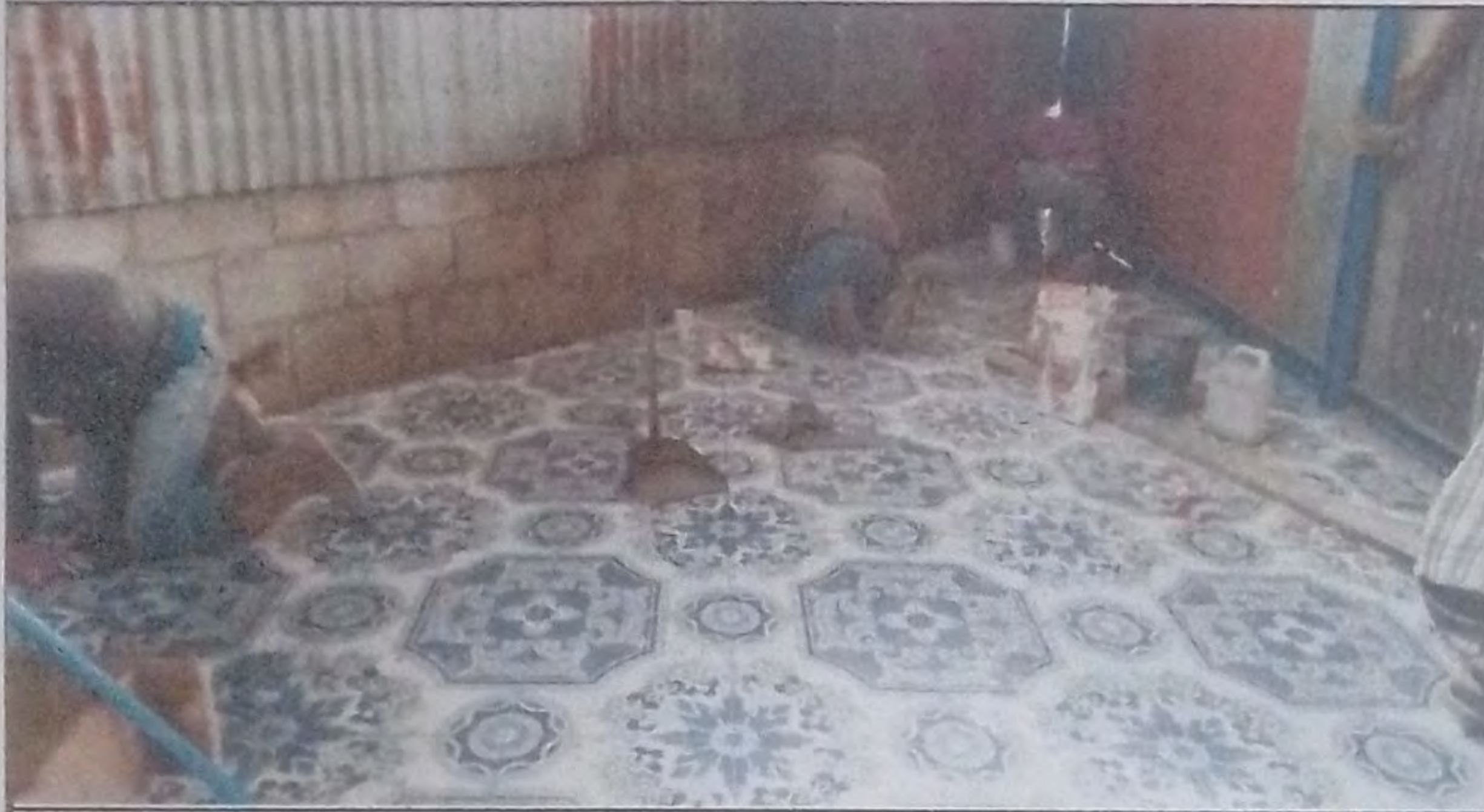
Foto1: Modulo 1; Sustitucion de piso ceramico.
